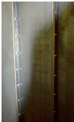
Sistema modulare imbullonato
